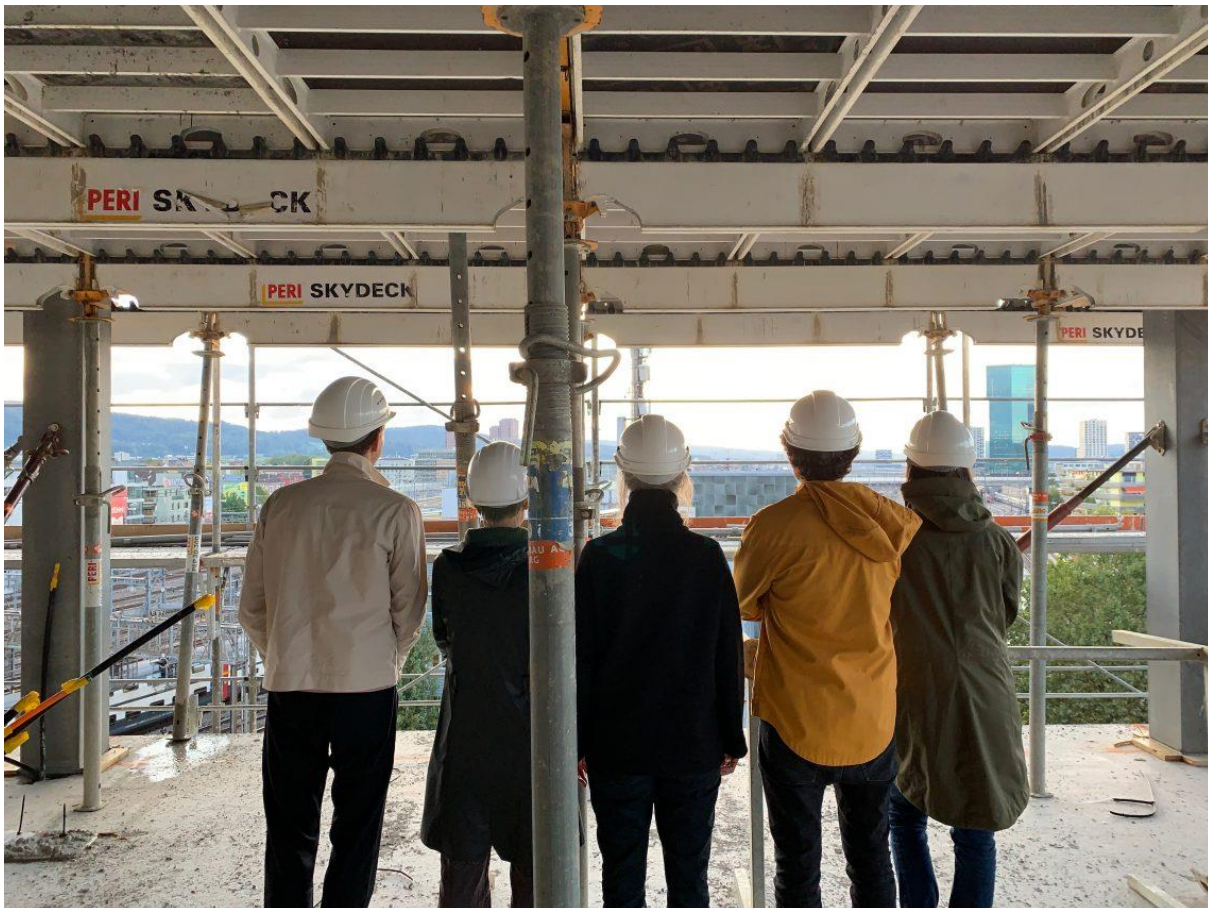
Bild: die Erko besichtigt die Zollhaus-Baustelle
