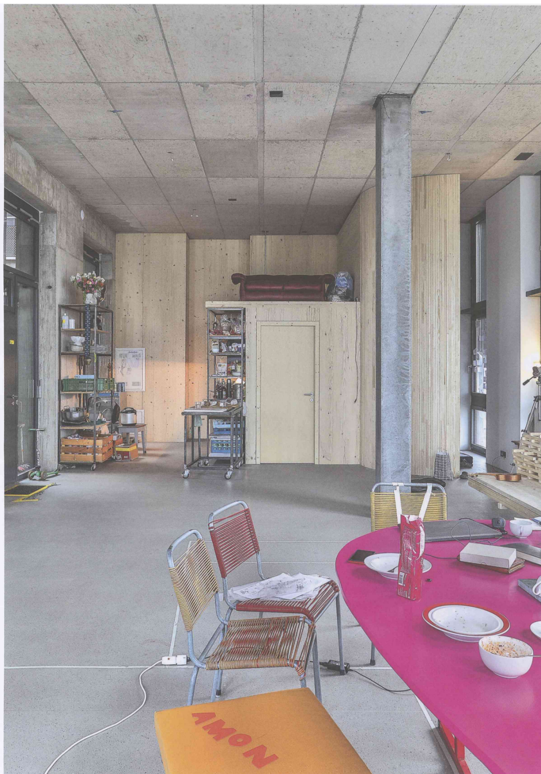
Die grösste der Hallenwohnungen im zweiten Obergeschoss wird gerade von ihren Bewohnern ausgebaut.
